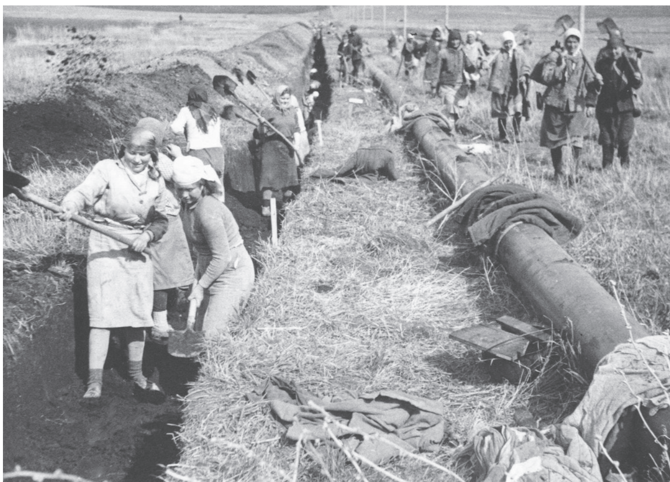
Строительство магистрального газопровода «Саратов-Москва»
